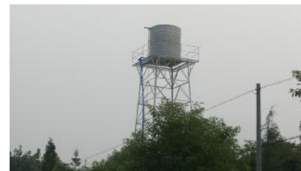
2008 年 7 月，进德公益为绵竹市精神病院修建水塔一座，耗资 66336 元。
